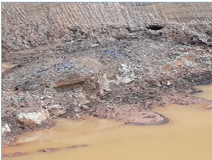
Foto 03 – Local de Rocha aflorante. Notar cantos vivos que devem ser eliminados com argamassa de concreto.
